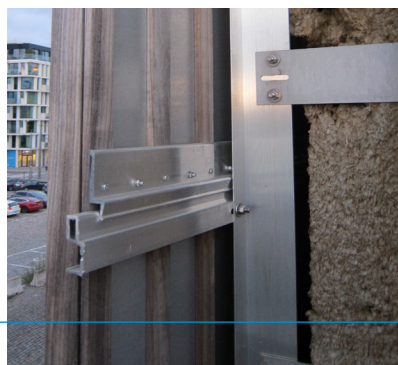
Bevestiging elementen aan de structuur
